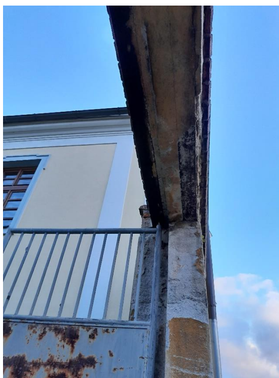
Novodobé zakrytí brány z válcovaných nosníků
