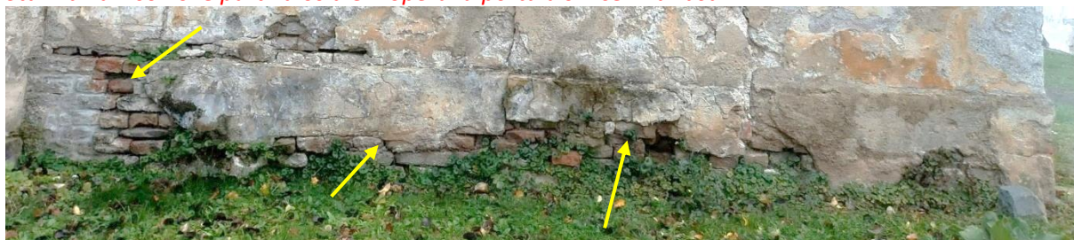
Na líci zdiva směrem do náměstí je vyplavení malty ze spár srážkovou vodou v soklové části ještě zřetelnější
