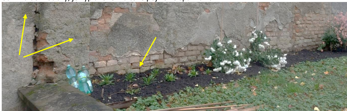
Stav zdiva v soklové partii a osídlení opěráku portálu sinicemi a řasami
