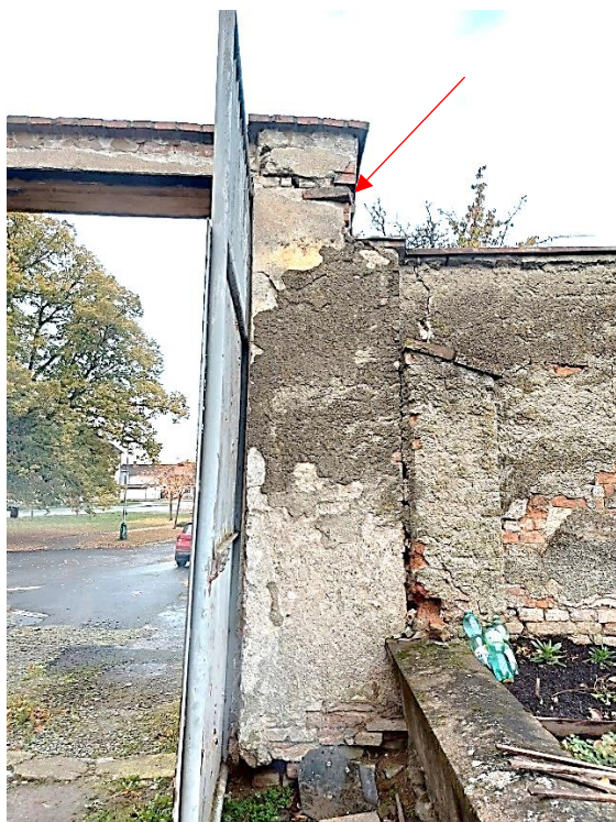
Narušení zdiva portálu v místě uložení válcovaných nosníků s vysunutou cihlou
