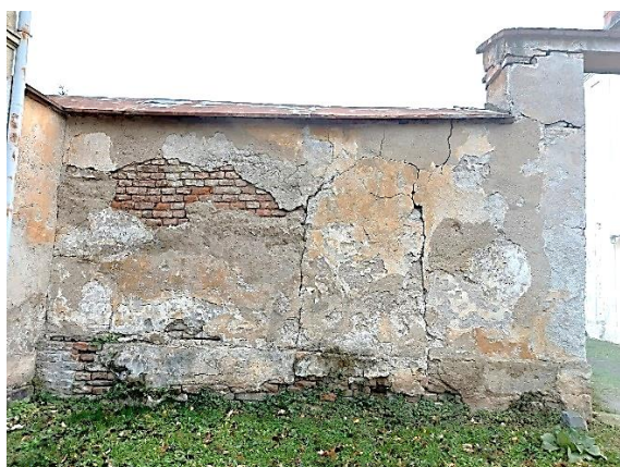
Pohled z náměstí s trhlinou ve tvaru výklenku
